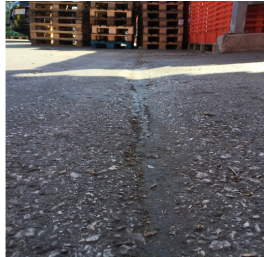
Aufsitzen der Ameisenstapler durch Unebenheit
