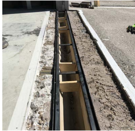
Setzen der neuen Entwässerungsrinne
