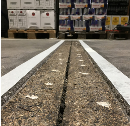
Vorbereiteter Übergang vorm austropox® Einbau
