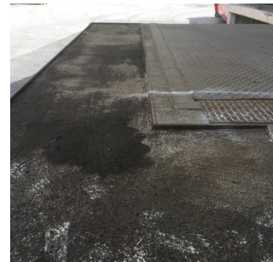
Vorbereitete Ladezone vorm austropox® Einbau
