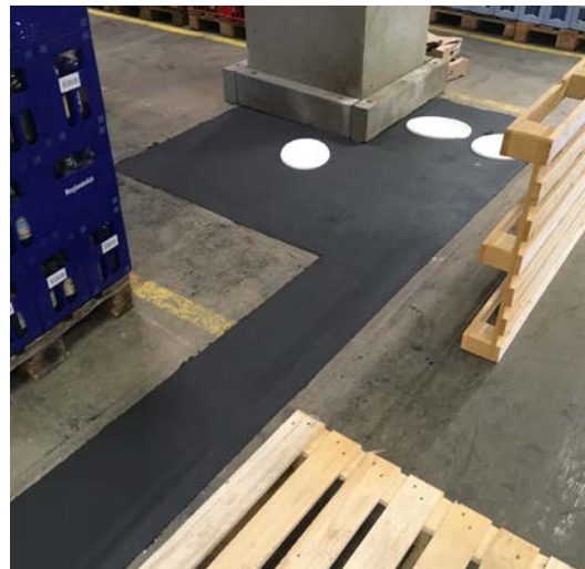
Lösung durch austropox®
