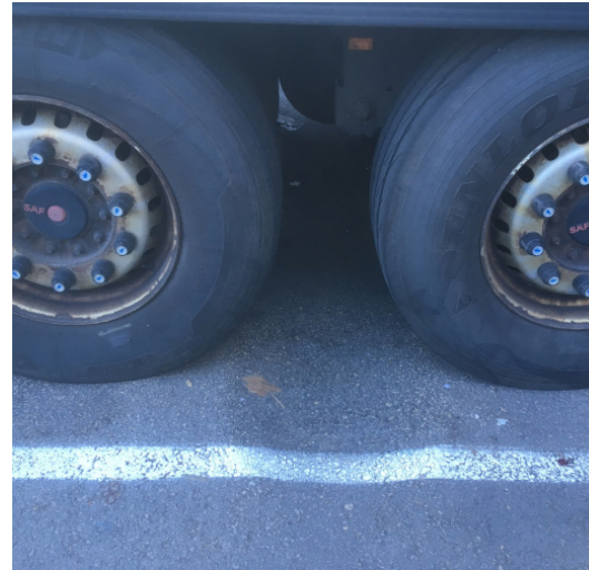
Asphaltverdrückungen durch LKW-Belastung
