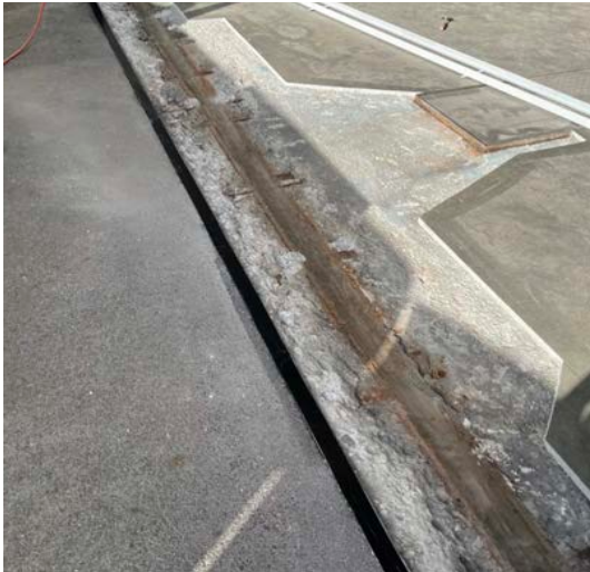
Neusetzung einer Entwässerungsrinne
