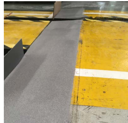
Lösung durch austropox®
