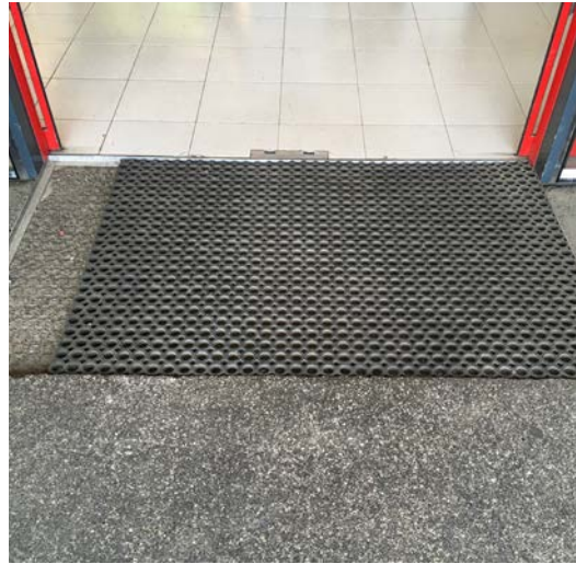
Unebene Eingänge durch Mattenbeläge
