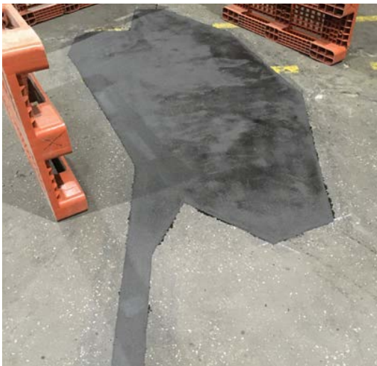
Lösung durch austropox®
