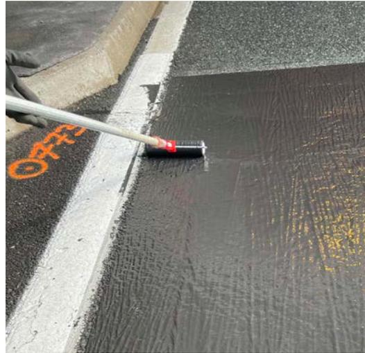
Auftrag der Deckschichtverstärkung
