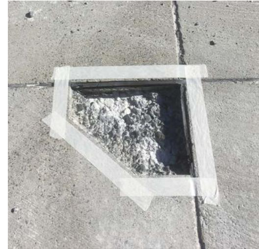
Kantenabplatzung im Detail
