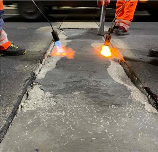
Unebenheit durch abgesenkte Betonplatte
