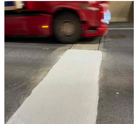
Fertige Deckschichtverstärkung im Tunnel
