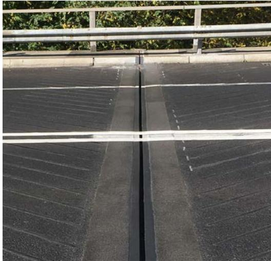
Stützrippenverguss auf PMMA-Basis
