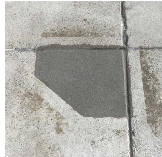
Mit austropox® sanierte Kantenabplatzung
