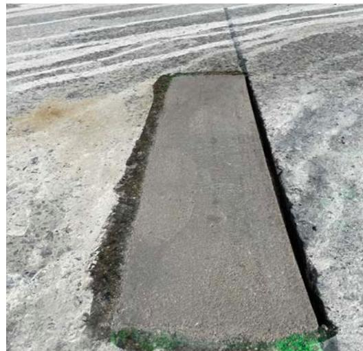
Mit austropox® sanierte Ausbruchstelle
