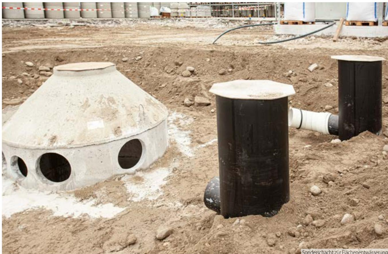
Sonderschacht zur Flächenentwässerung
