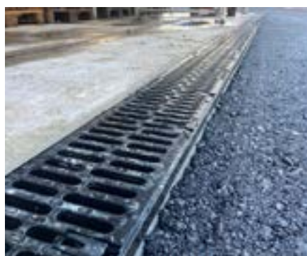
Einlaufkasten Langform mit Schlammweimer aus Kunststoff
