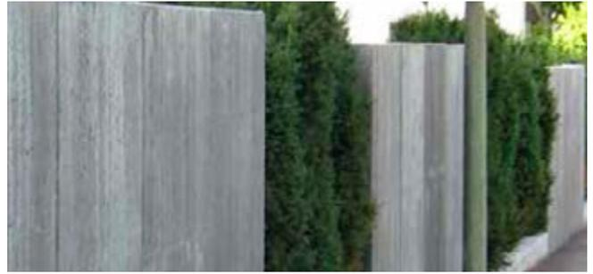
Die Winkelelemente ergänzen die Reihe der Winkelstützmauern mit niedrigen, jedoch längeren Fertigteilelementen. Hierdurch werden die Kosten je Laufmeter reduziert und auch die Montagedauer verkürzt. Vielseitige Einsatzbereiche für Oberflächengestaltungen, Stützmauern, Grundstückseinfassungen aber auch Hochwasserschutz können hiermit erreicht werden.
